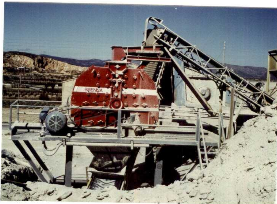
Foto nº 3. Detalle de una planta de áridos mostrando un molino para la producción de arena.
